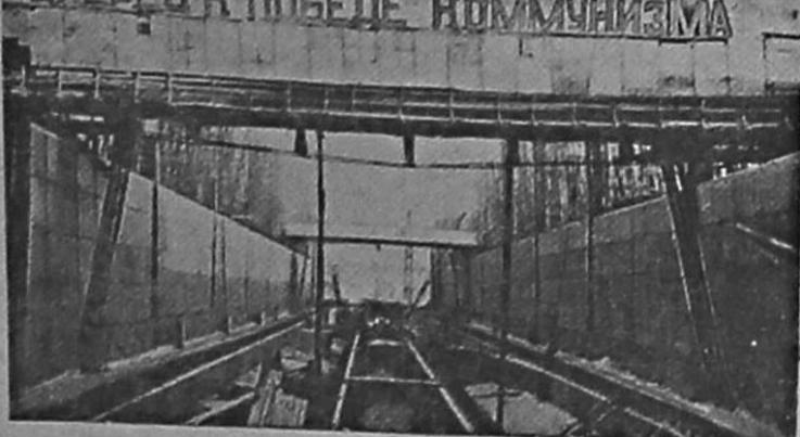
Куйбышевгидрострой. Первый пусковой объект Куйбышевского гидроузла — двухкамерные судоходные шлюзы — вступит в строй весной 1955 года. Сейчас на шлюзах идет монтаж гигантских створок рабочих ворот, установка закладных частей и механизмов управления, укладка бетона и монтаж арматуры на самых верхних ярусах. На снимке: общий вид сооружения левовой камеры нижних судоходных шлюзов.
